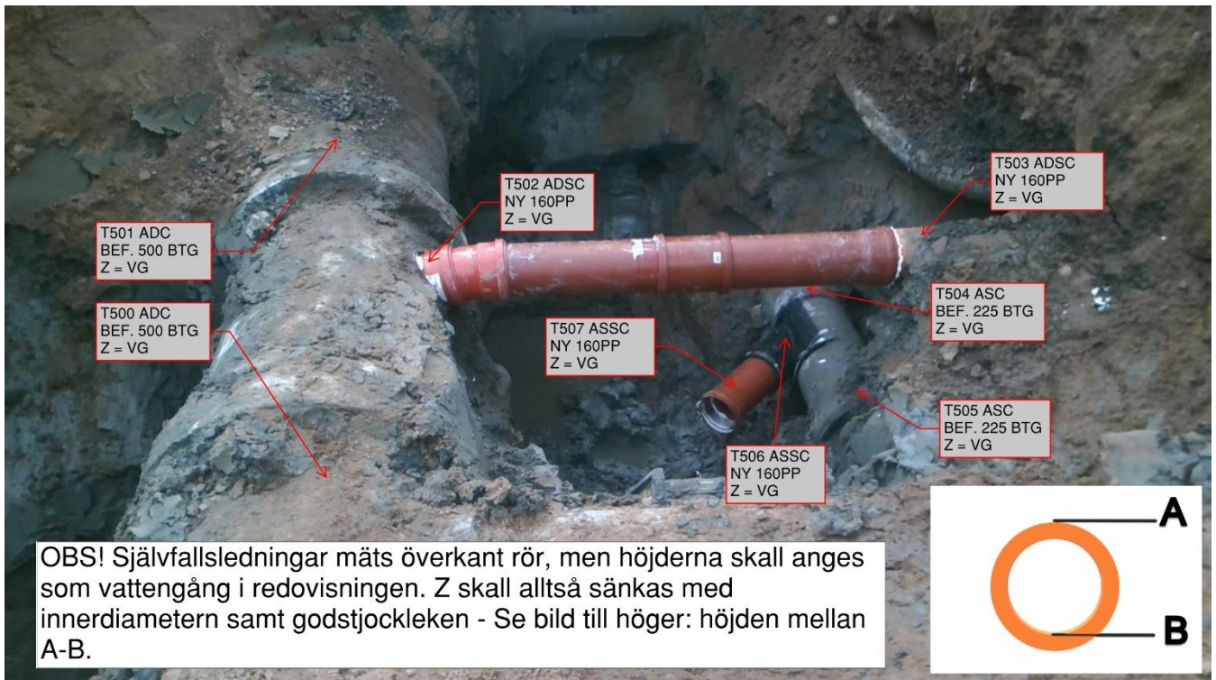
Bild 4: Nylagda spill- och dagvattenserviser.
