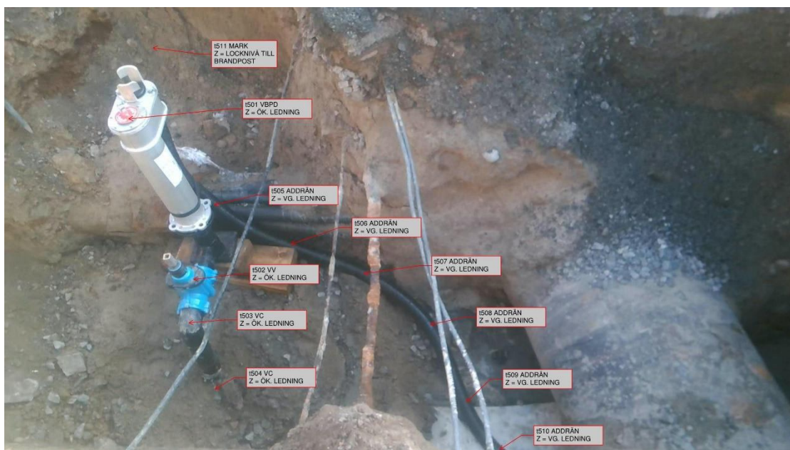
Bild 1: Brandpostledning med dränering.
