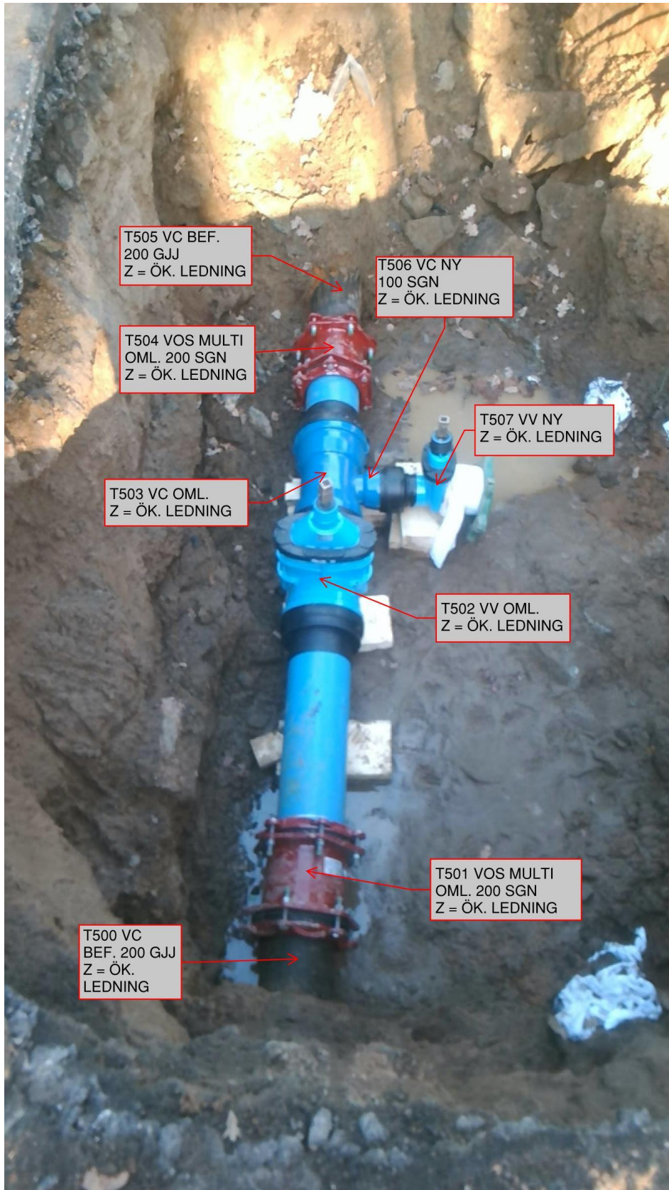
Bild 3: Omlagd huvudledning vatten med ett nytt stick och ventil.
